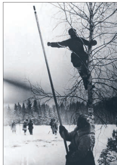
На прокладке связи
